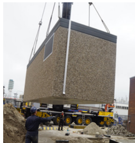
Het transformatorhuis werd in één dag geplaatst met een telescoopkraan met een capaciteit van 250 ton.
